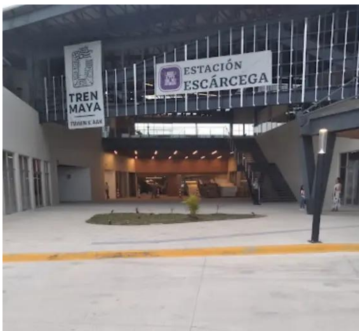
Ilustración 7 Estación del Tren Maya en Escárcega
